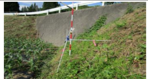
境界杭の復元状況
