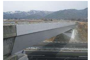
水路橋耐震補強（箕輪地区）
