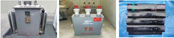
トランス（変圧器） コンデンサ（蓄電器） 安定器
