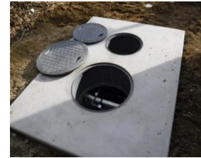
合併処理浄化槽の設置
