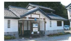
道の駅トイレリニューアル
