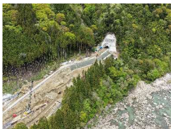
木曽川右岸道路 (読書ダム～戸場：1号トンネル)
