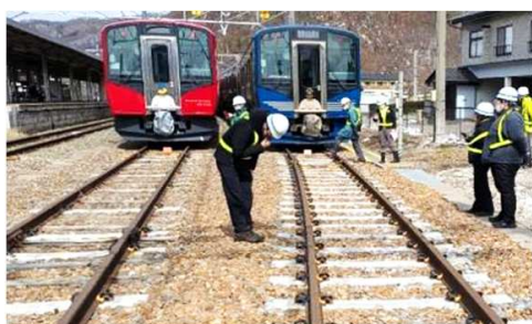
木マクラギ ⇒ プレストレストコンクリート化したマクラギ
