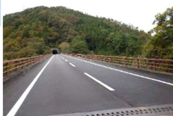
大津大橋修繕工事
