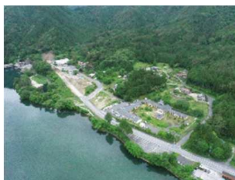
木曽川右岸道路
