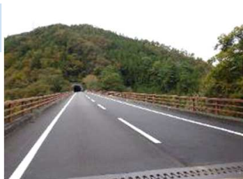
大津大橋修繕工事
