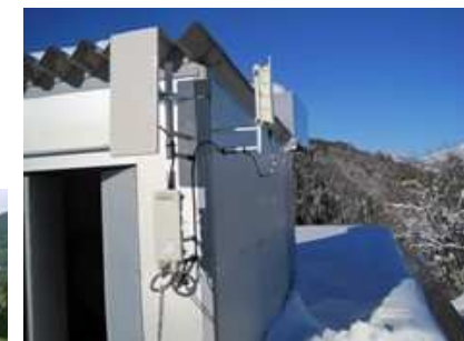
情報基盤整備 小谷工区
