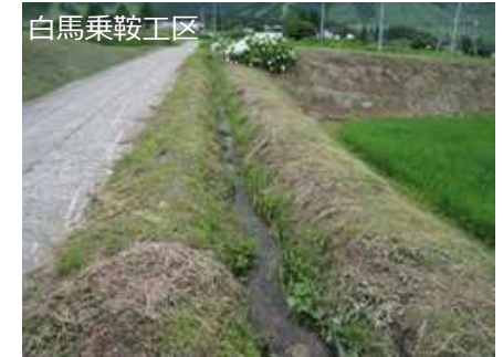
ほ場内の土型水路
