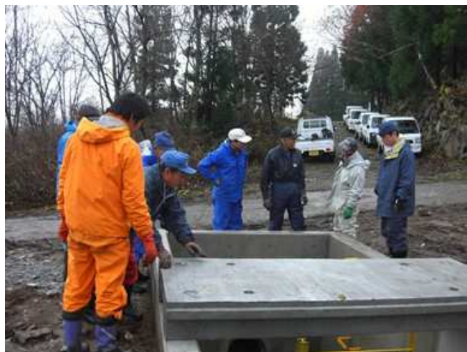
（土倉工区）暗渠水路の保守管理
