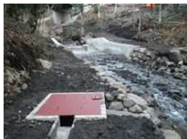
用排水施設整備 松沢工区
