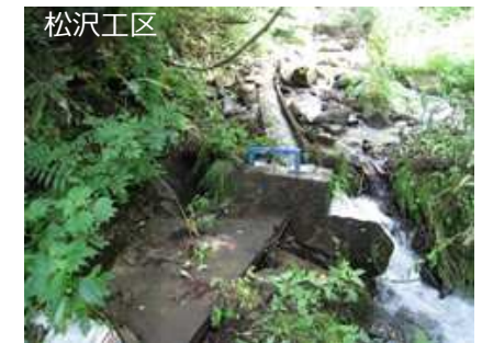
河床の変動の度に取水位置を上流に移動して水を取っている
