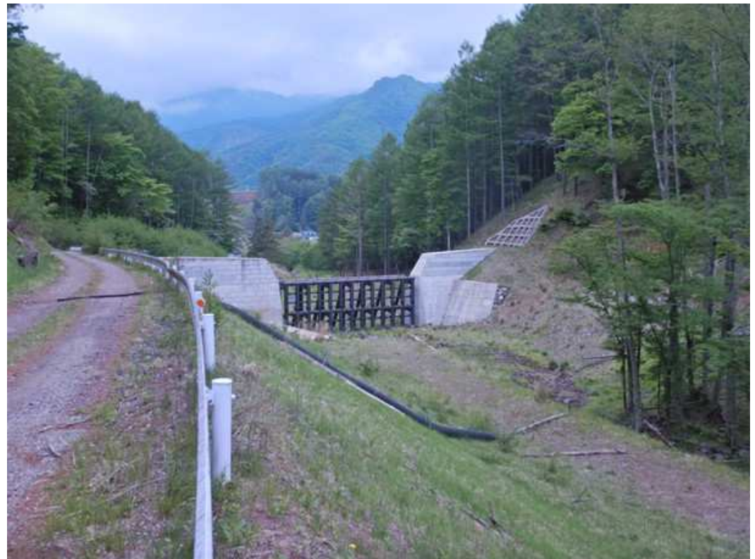
1号堰堤上流より下流の保全対象を望む
