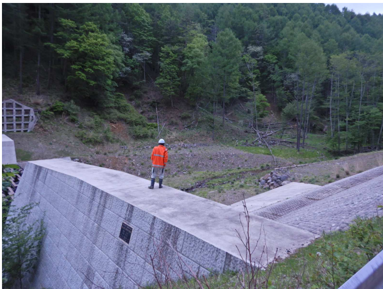
1号堰堤 施設点検
