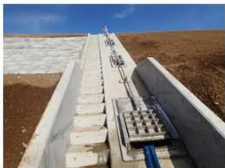
取水施設の改修
