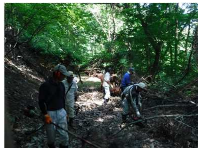
管理道の保守管理（倒木撤去）
