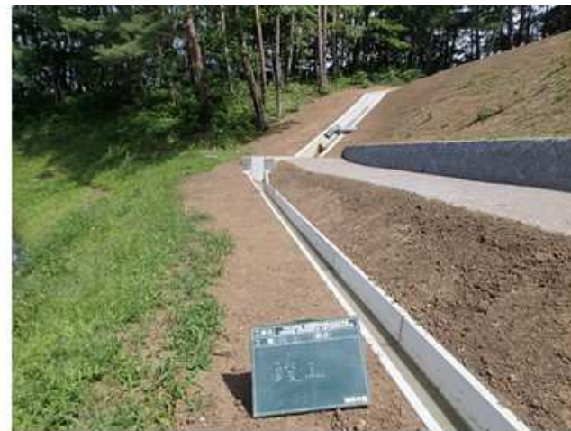
周辺地形に併せ、地形変状を小さく、周辺樹木の伐採も抑えて施工した洪水吐水路
