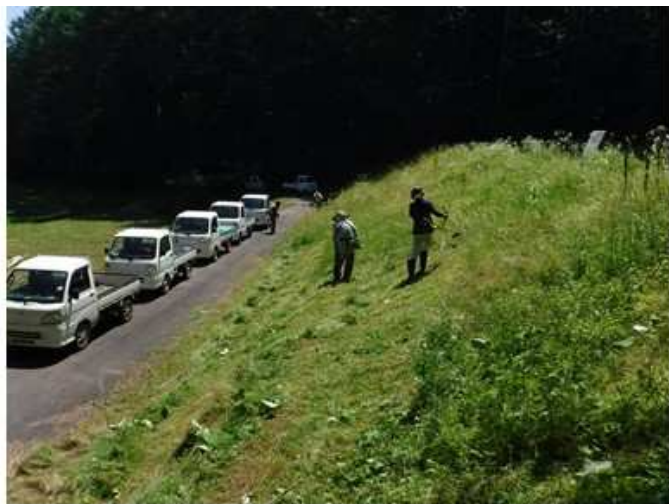
組合員による堤体の草刈り
