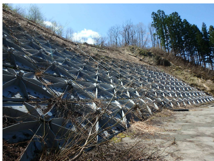
抑止工(アンカー工)
