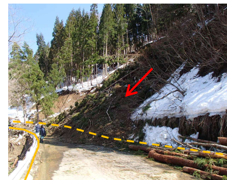
(林道大川線の被災状況)
