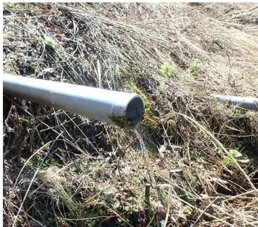
集水ボーリング孔の点検
