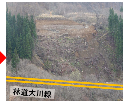
(災害関連緊急地すべり防止事業による頭部排土後の状況)
