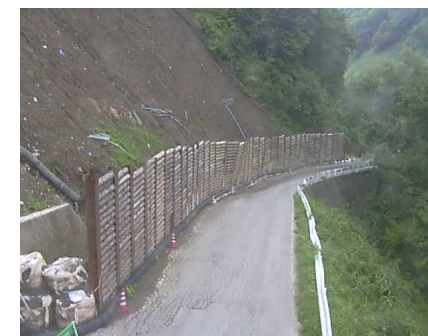
(仮設防護柵の設置状況)
