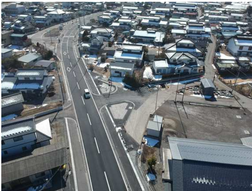
両側歩道設置の状況
