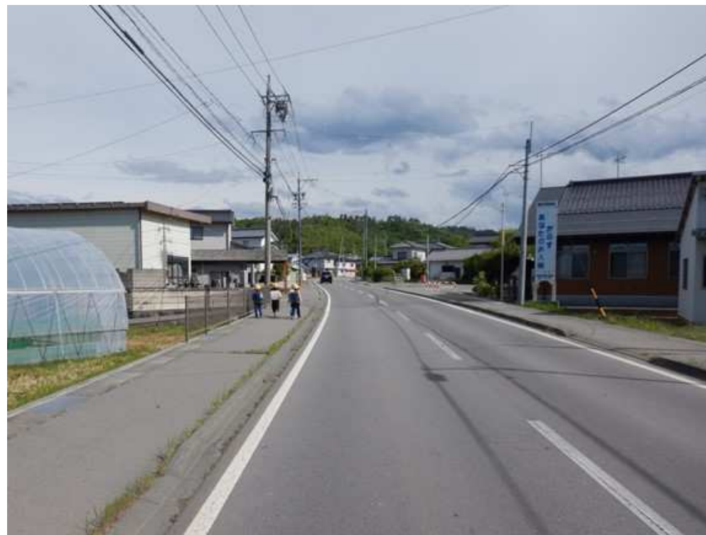
両側歩道設置の状況
