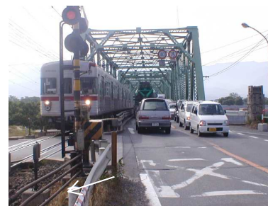
すれ違い困難な状況
