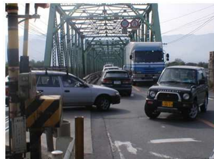
整備前の踏切交差点
