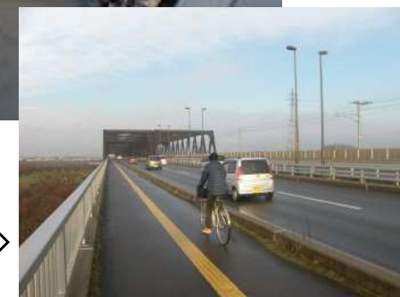
整備後の交通状況
