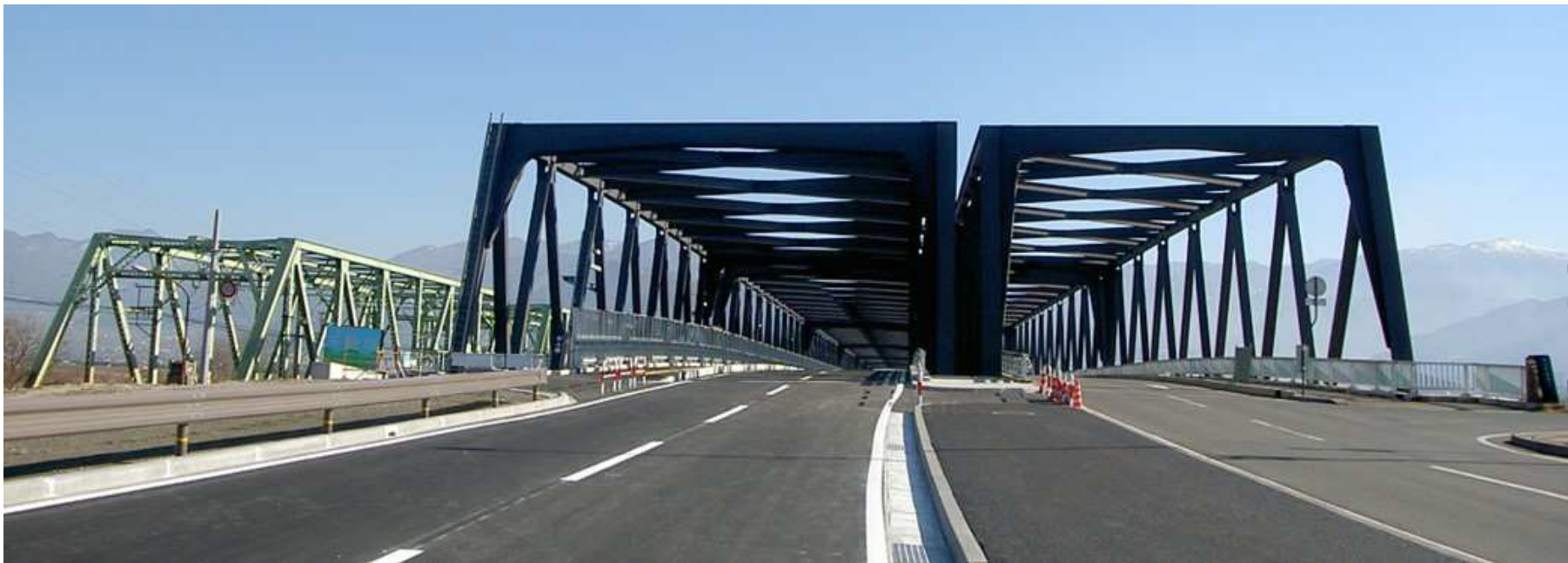
長野市側から須坂市側を望む
