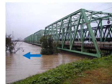
千曲川出水時の状況
