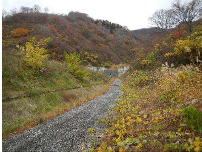
【導流堤の植生状況】
