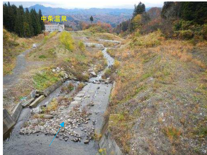
【溪間工の整備により溪床が固定化され、植生が回復】
