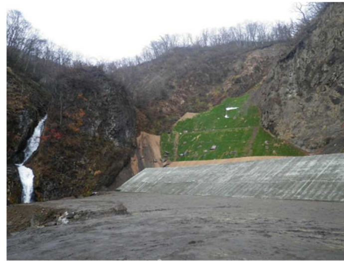
【現場発生材を活用した土堤（補強盛土工）】
