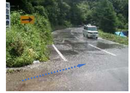
埋設管からの漏水状況
