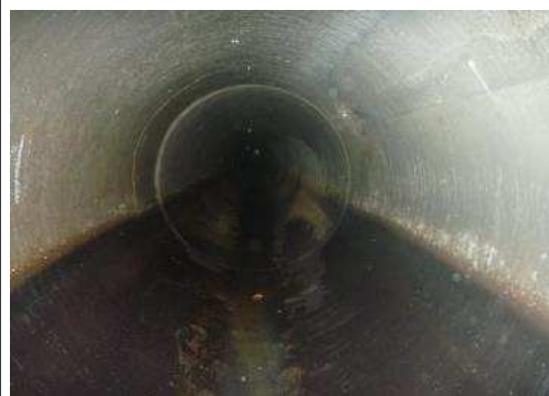
(実施前) 管内部の状況
