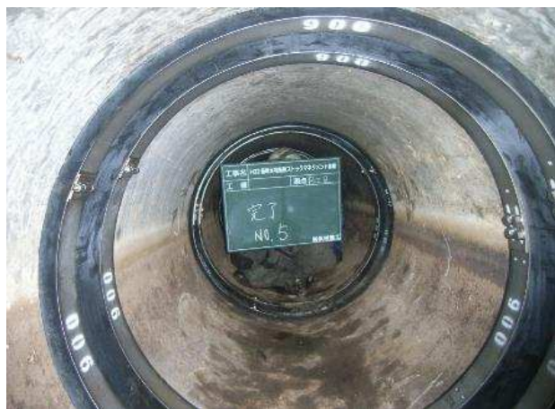
【継手バンドによる補修】
