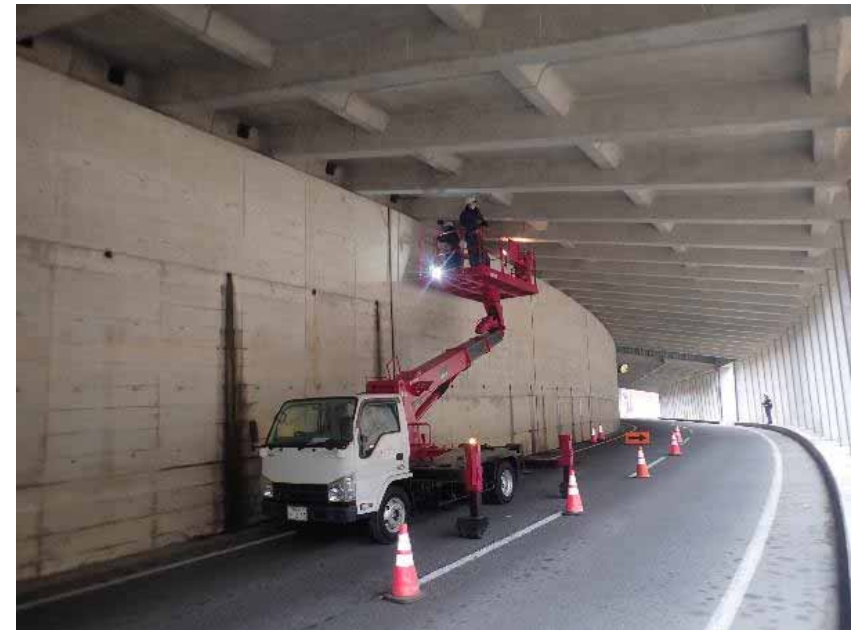
高所作業車による近接目視実施状況（定期点検）
