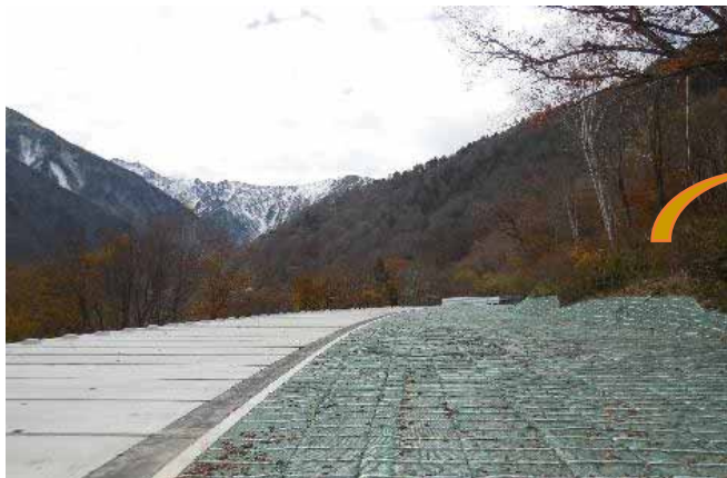
完成直後（天井部）
