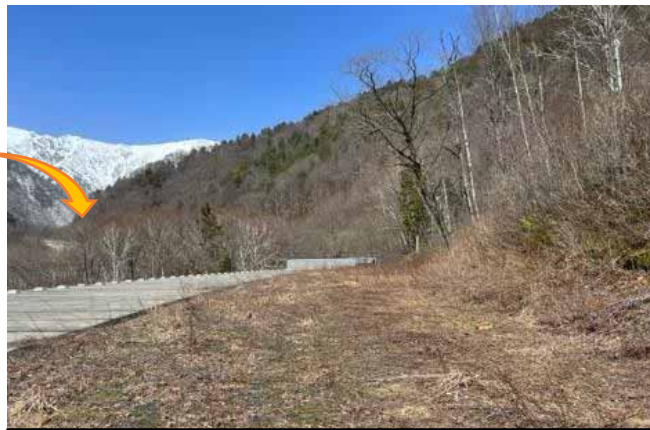
令和5年4月中旬撮影（天井部）
