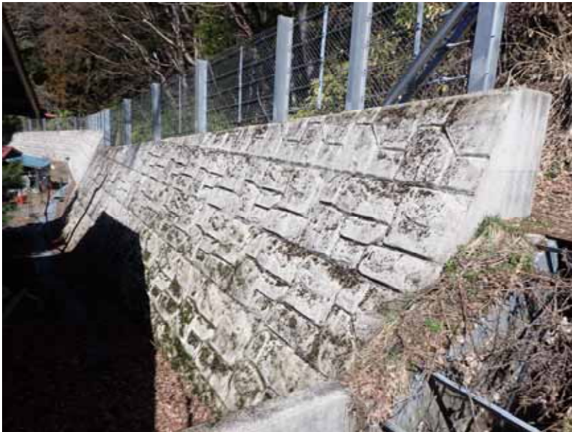
化粧型枠状況
