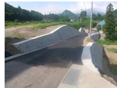
集落道整備 須合工区
