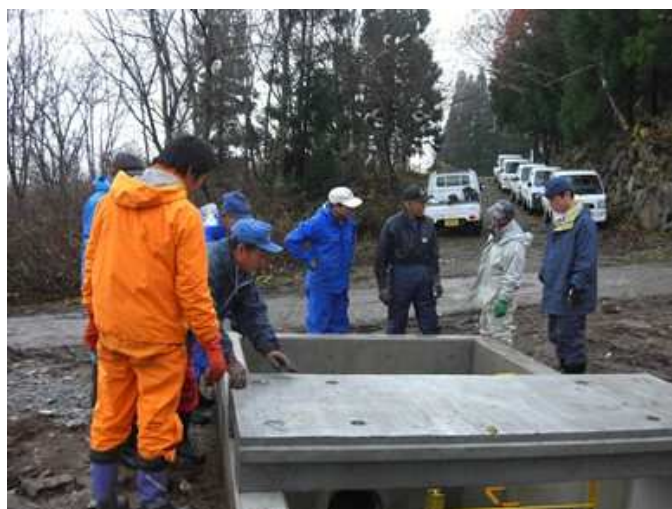
（土倉工区）暗渠水路の保守管理
