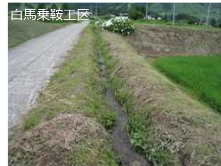
ほ場内の土型水路
