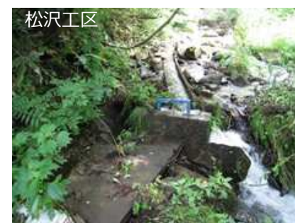
河床の変動の度に取水位置を上流に移動して水を取っている
