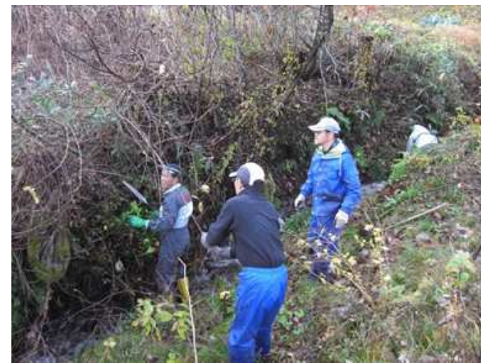
（深原工区）水路周辺の草刈り
