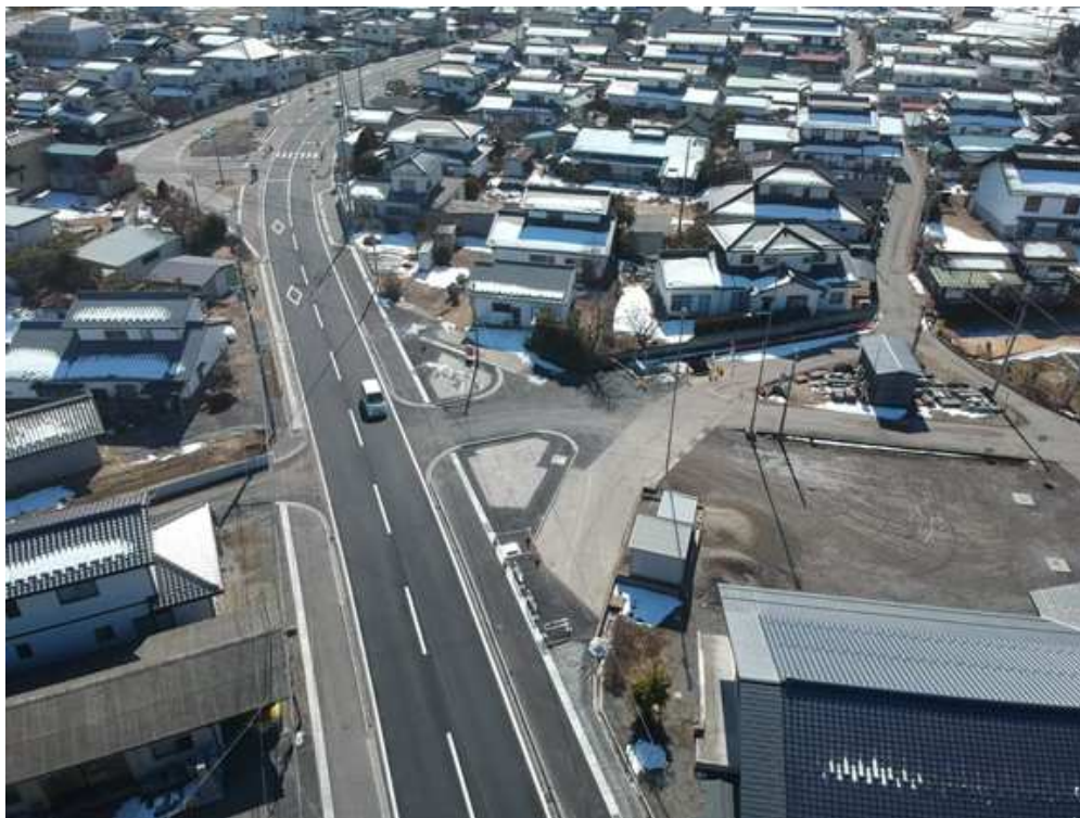
両側歩道設置の状況
