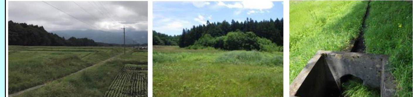
全景(小六工区)
