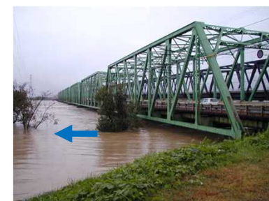
千曲川出水時の状況
