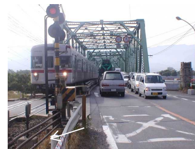
すれ違い困難な状況
