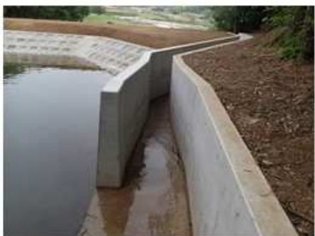
洪水吐の改修
