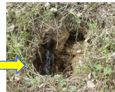
漏水孔（拡大）
