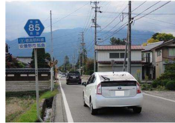
現道状況 (線形不良、幅員狭小)
