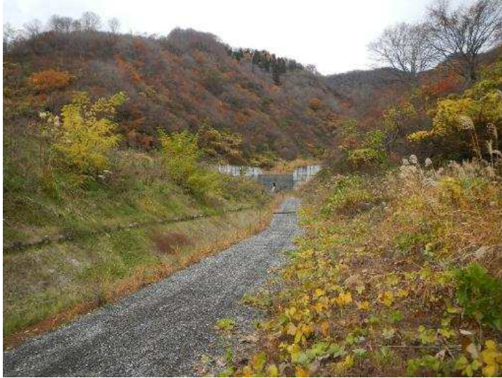
【導流堤の植生状況】
