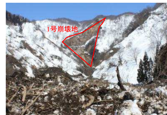
【崩落土の堆積状況】
