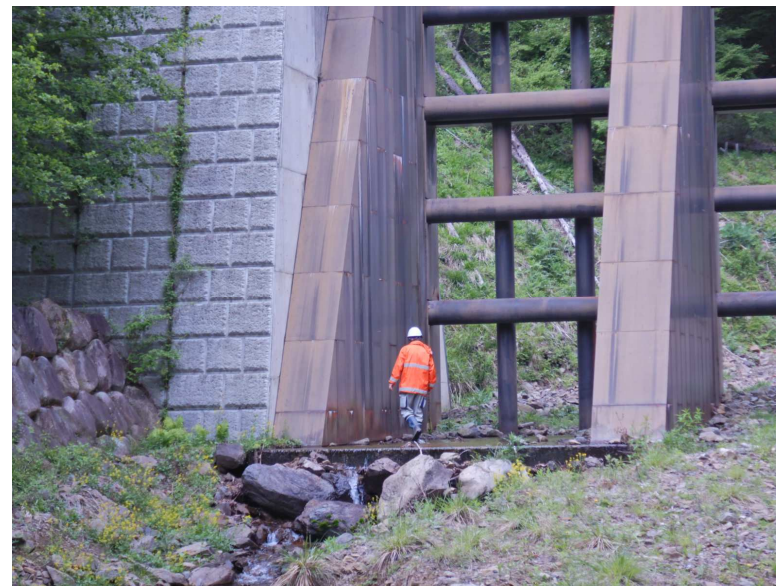
2号堰堤 施設点検
