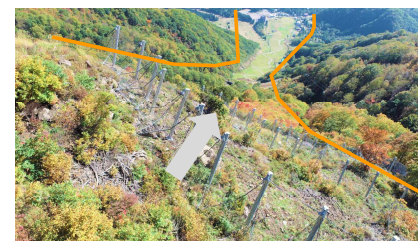
雪崩施設から下方向
