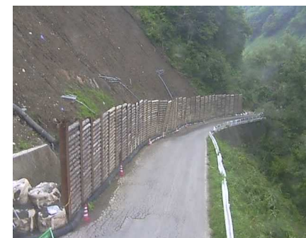
(仮設防護柵の設置状況)
