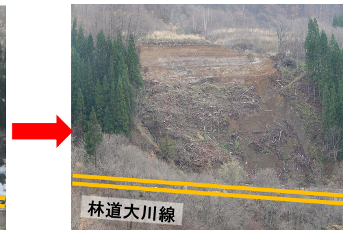
(災害関連緊急地すべり防止事業による頭部排土後の状況)
