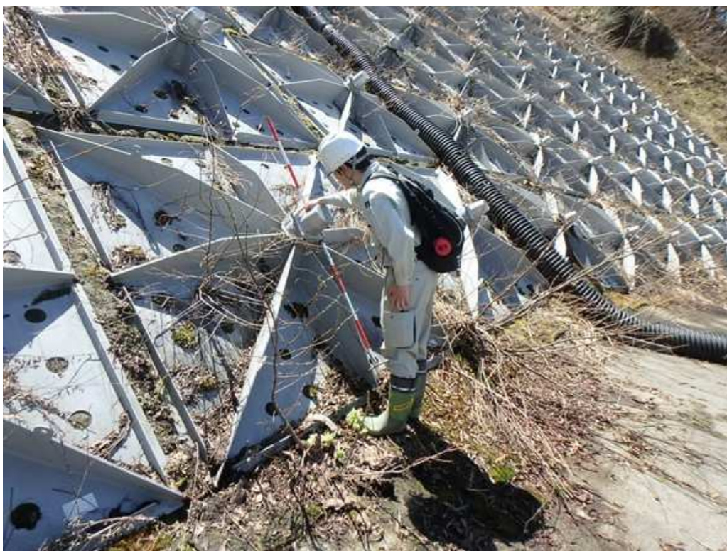
アンカー工の腐食、ボルト緩み等の点検
