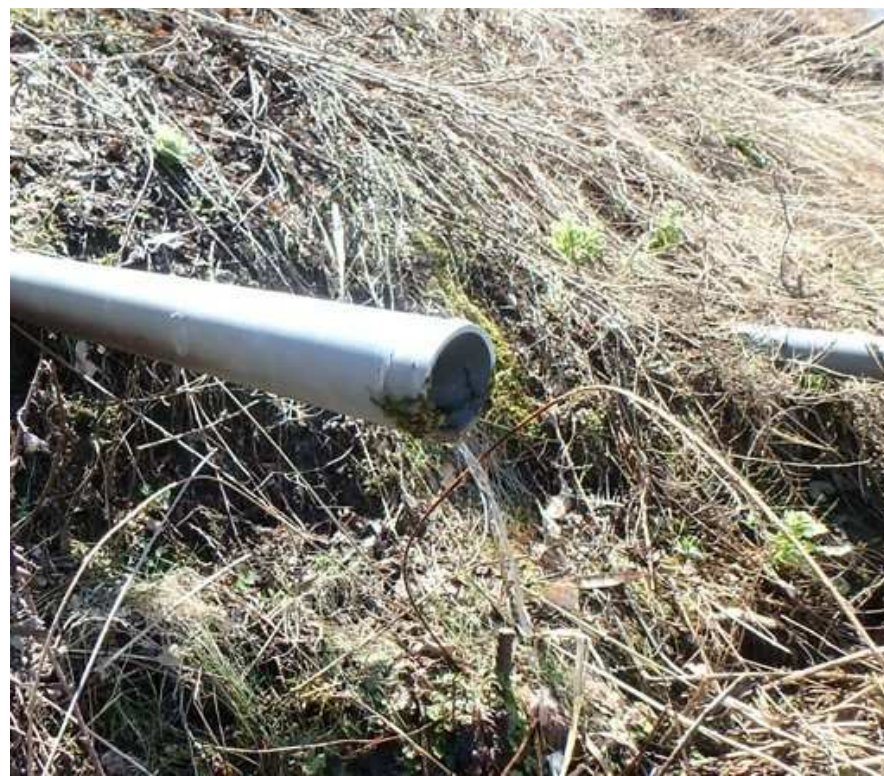
集水ボーリング孔の点検
