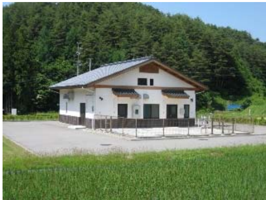
・乱橋地区農業集落排水処理施設
