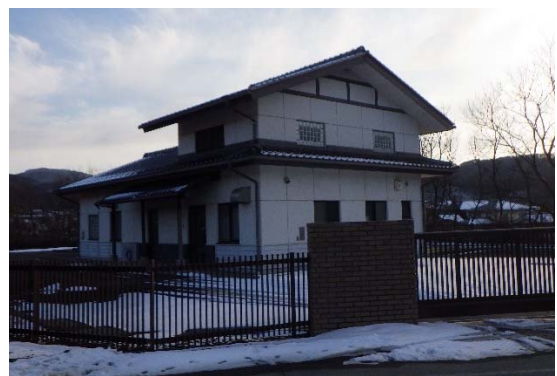
・東条地区農業集落排水処理施設
