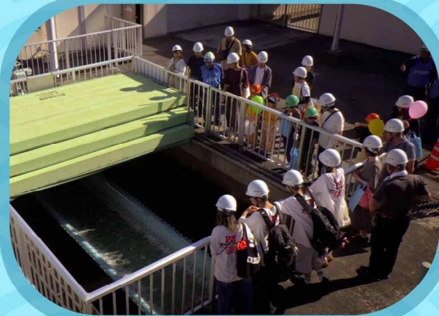
処理場見学 (3 過水槽)
