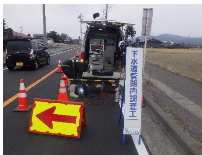
調査状況全景
