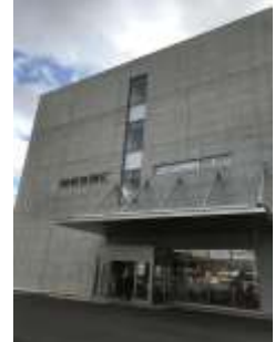
工業系試験場を集約し4階建ての建物を新築（拠点交付金等利用）
