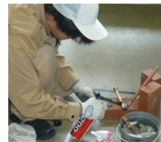
配管を溶接する様子 （松本技術専門校：冷凍空調設備科）
