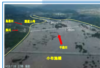
立ヶ花狭窄部掘削
