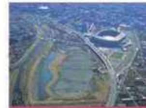
洪水調節施設
