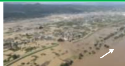
長野市穂保地先の堤防決壊、 湯水被害状況
