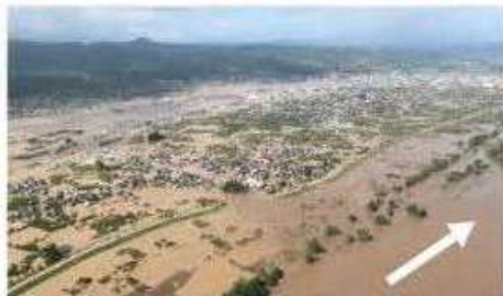
長野県長野市穂保地先の 堤防決壊、浸水被害状況
