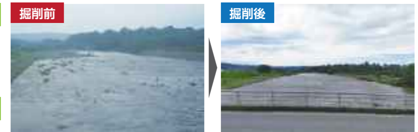
御影橋から下流の掘削状況
