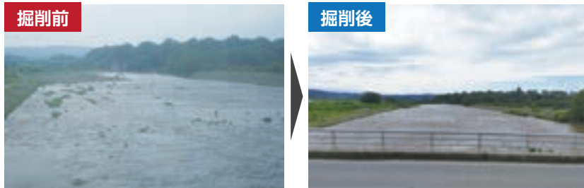
御影橋から下流の掘削状況
