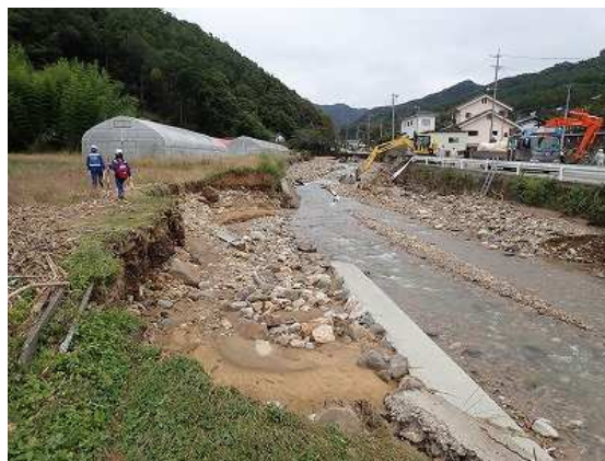
写真 1-9 余地川被災状況写真
