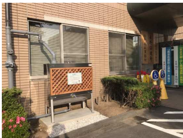
写真 4-3 雨水貯留タンク設置状況
