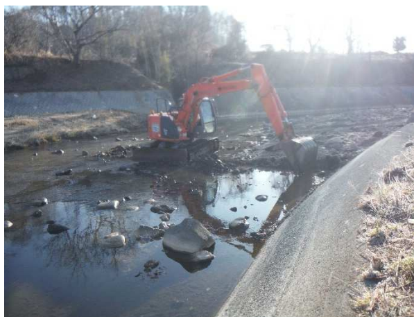
写真 3-1 堆積土砂の除去の様子
