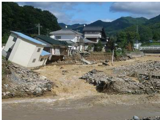
写真 1-8 抜井川被災状況写真
