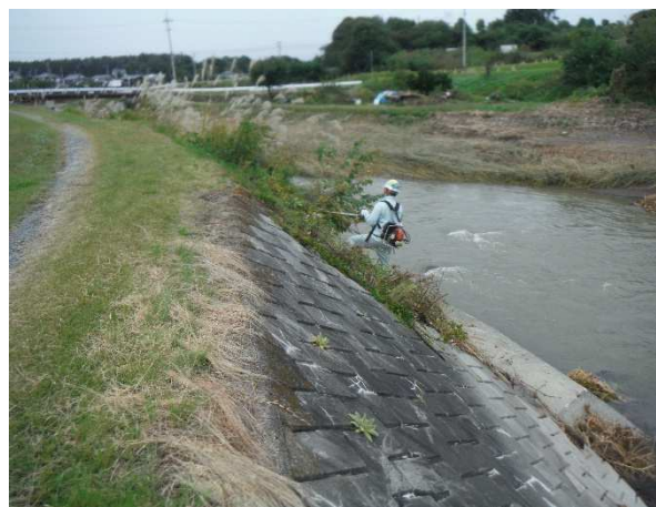
写真 3-2 法面の除草の様子
