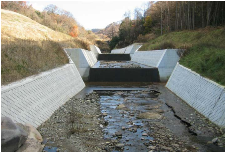
災害防除として河川の付替え工事を実施
