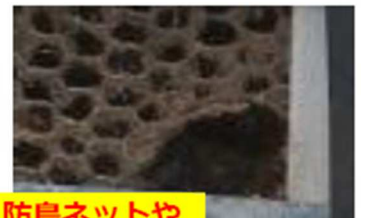
防鳥ネットや 鶏舎破損の補修
