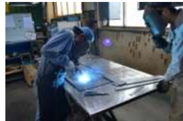
画像は炭酸ガス・アーク溶接
