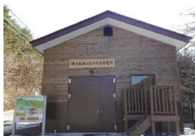
陣内森林公園発電所
