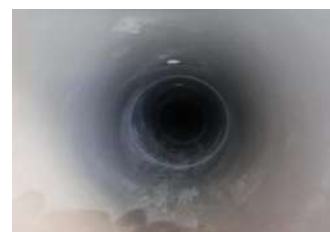
新設トンネル
