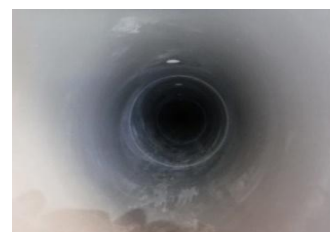
新設トンネル
