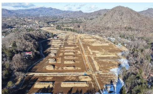
幅員の狭い農道を大型農耕車両がすれ違いできるように拡幅整備 (県営畑地帯総合土地改良事業南牧野辺山地区)
