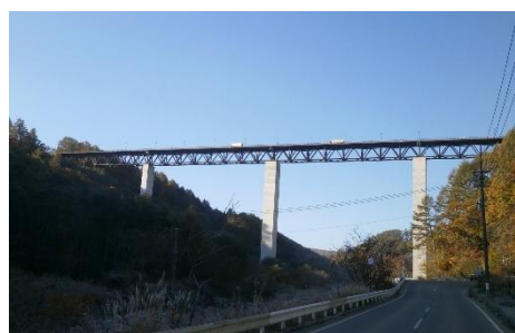
農作物輸送の効率化を図るため 県単農道で整備した川上大橋
