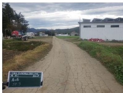
幅員の狭い農道を大型農耕車両がすれ違いできるように拡幅整備 (県営畑地帯総合土地改良事業南牧野辺山地区)
