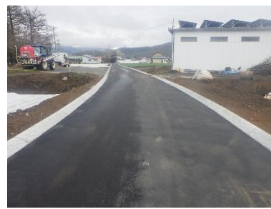
幅員の狭い農道を大型農耕車両がすれ違いできるように拡幅整備 (県営畑地帯総合土地改良事業南牧野辺山地区)
