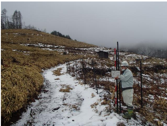
7 野生鳥獣侵入防止柵設置
