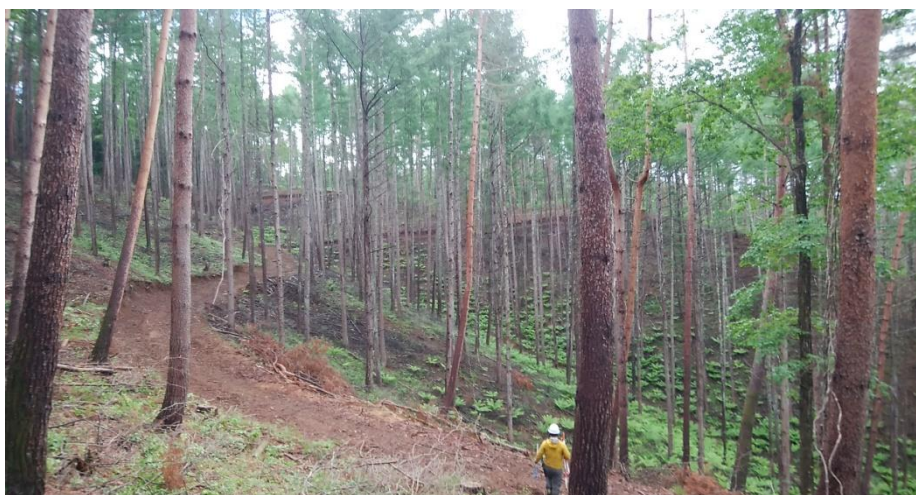
佐久穂町 中尾日影 間伐 作業道開設
