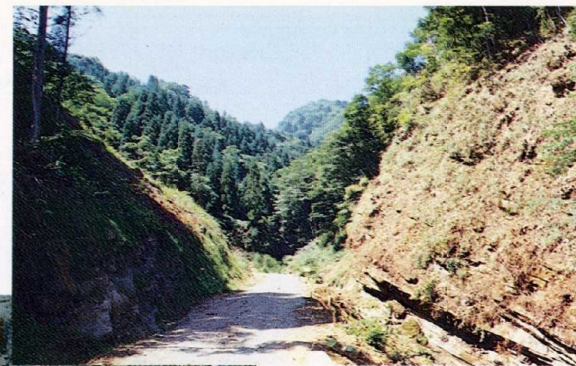
着工前ダムサイド ▶
