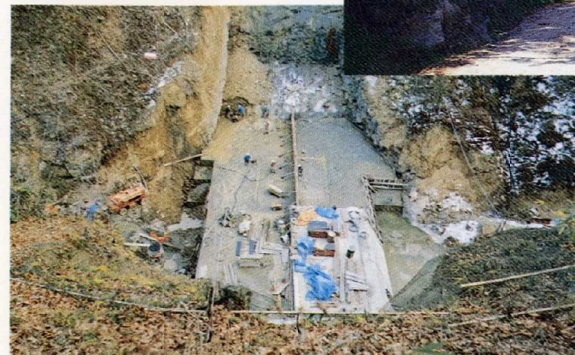
◀ ダム本体打設開始
