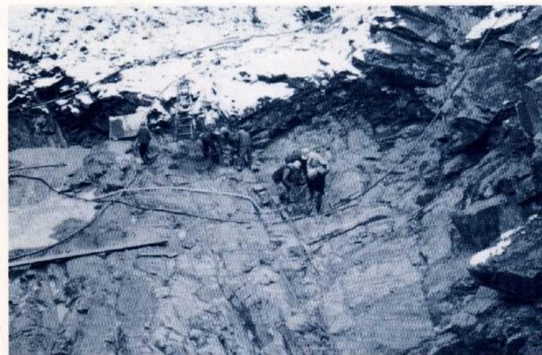
ダム工事中(基礎)
