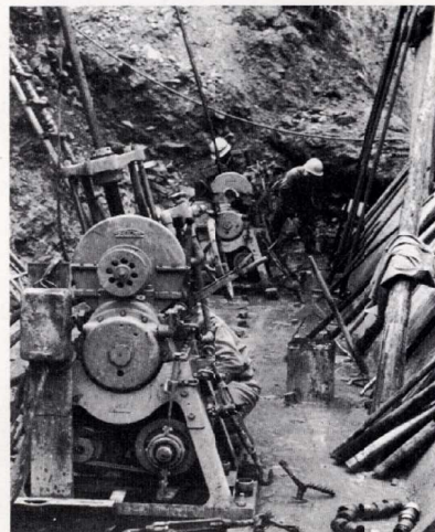
カーテングラウト工
