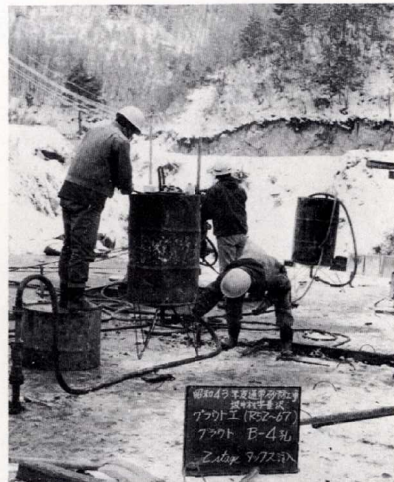
コンソリ,及コンタクトグラウト工
