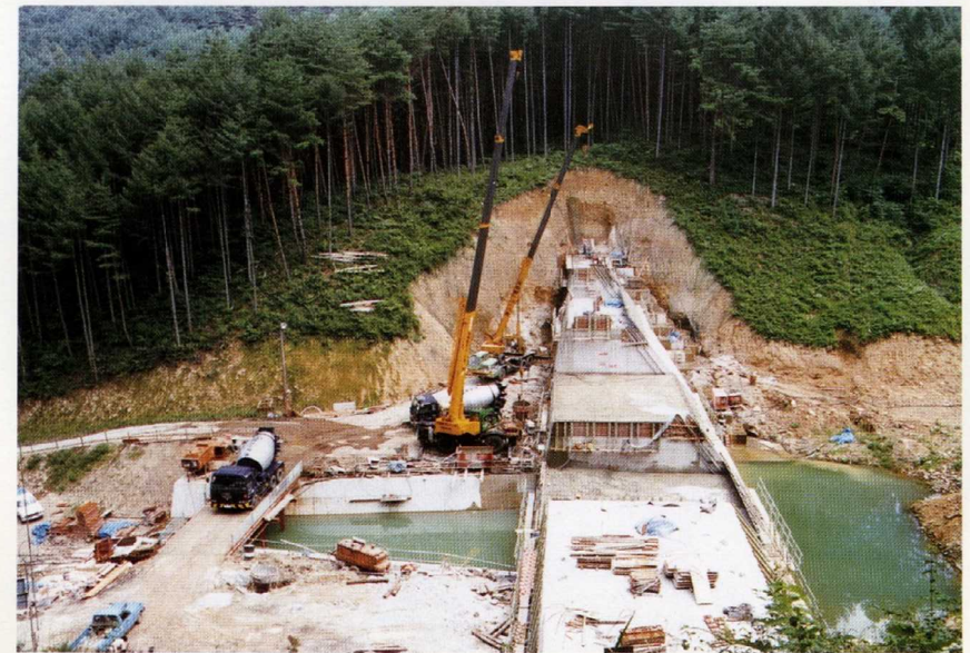
施工中 昭和63年8月
