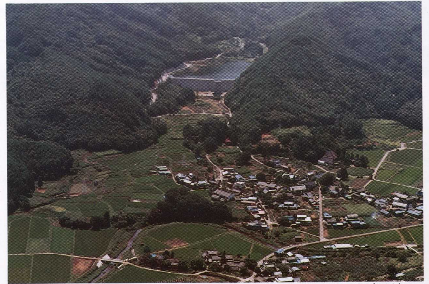
ダムの完成により安全が保たれる矢倉地域
