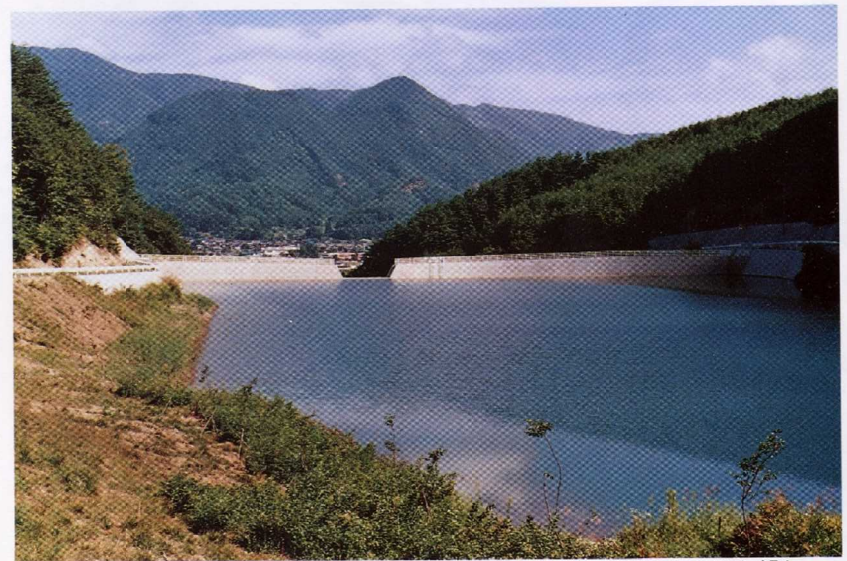
ダム上流より麻績村中心地を望む
