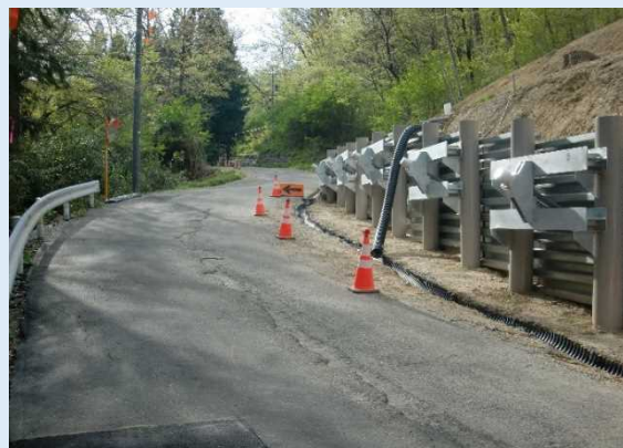
対策工事了完了(R3.3月)
