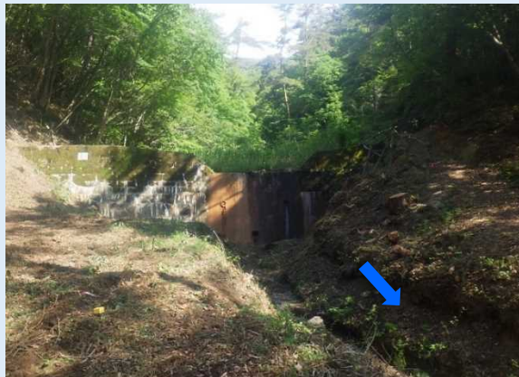
着手前(既設堰堤:昭和49年完成)
